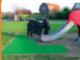
Esempio di posa in opera
